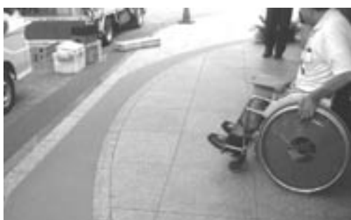
既存の段差に設けられたスロープを検証する
