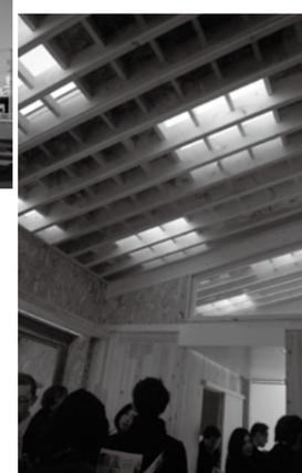
ガラスの天窓と太陽電池パネル、太陽熱集熱パネルを格子状に組み合わせた「呼吸する屋根」の造りが印象的でした。
