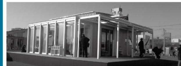
「重ね着するすまい」をコンセプトに、建物の中心に浴室やキッチン、エアコンなどをまとめた「設備コア」を配置し、それを「居住ゾーン」が取り囲み、その周囲をさらに日光の差し込む「Nobi-Nobi」ゾーンが囲む三重構造のプランが目新しい。
