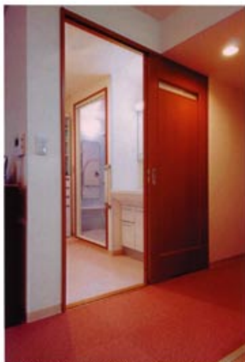
A 廊下との段差が無くなった洗面室入口。手摺は福祉用具相談員と連携して位置や高さを決定。
