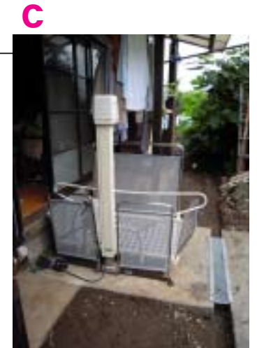
C ▲昇降機ベースとスロープコンクリートの間は雨水の通り道となっており、グレーチングを入れ雨水が滞留しないようにした。
