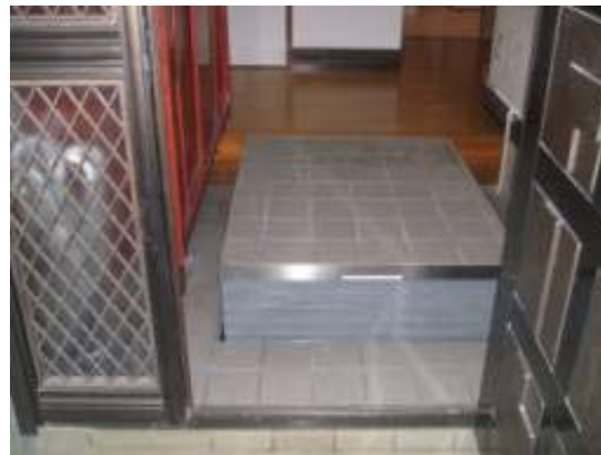
⑤玄関に埋め込み式段差解消機を設置
