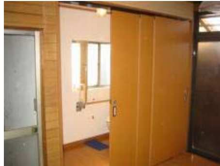
B番 入口ドアを吊戸とし敷居を設けない車椅子で使用可能な洗面台を設置した
