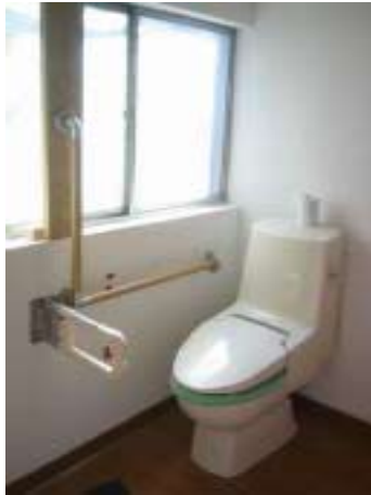
A番 便器横のL型手すりの設置のため、既存窓の前に補強板を取付け手すりを設置した
