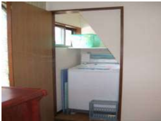
④ドアを新設し洗濯機を設置
