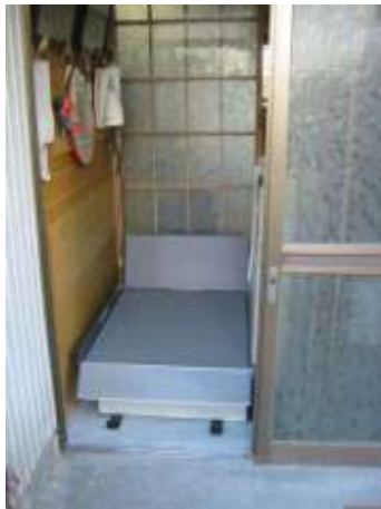
4番 一回目の玄関改修工事では、マイナス435のために、段差解消機をリースして設置しましたが、二回目の改修工事では、仮設スロープで出られるように、玄関ドアを親子ドアとし、幅1000以上を確保しました。
