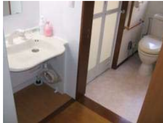
②旧便所スペースを半分に区切り洗面器・洗濯機を設置
