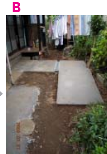
B ▲同一敷地内に借家が4棟建っている為、全体のコンクリート敷きは出来ず、入口部分において昇降機のベースとスロープ工事を行った。
