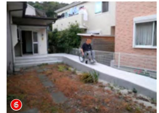
■ 外出 玄関タタキをかさ上げし、車いすのまま外部へ。7.7mと長いスロープのため、途中で平らな踊場を設置し、脱輪防止のために車止めを設けた。車への乗り込みスペースをコンクリート整地した。スロープは1/15の勾配とし自力で無理なく登ることを可能にした。レンタルの段差解消機も検討したが、他のサービスの圧迫と今後のレンタル料の負担、メンテナンスを考慮しコンクリートのスロープを提案した。
