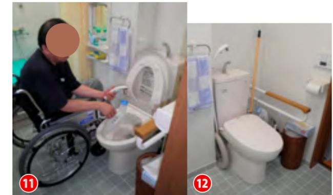
■ トイレ 便座高さ450mmの車いす用トイレを選定し、移乗負担を軽減した。しびん、カテテルを洗浄するため、便器横の壁にシャワーを取り付けた。シャワーヘッドから水滴が床に落ちるのを防ぐため、便器の手洗器に水が落ちるように工夫した。上体を左側に大きく倒せるように壁からトイレの芯までを550mmとした。
